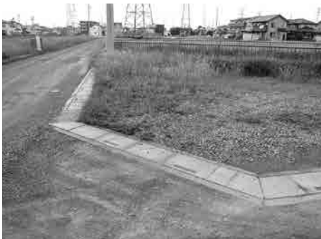
隅切りされた道路
