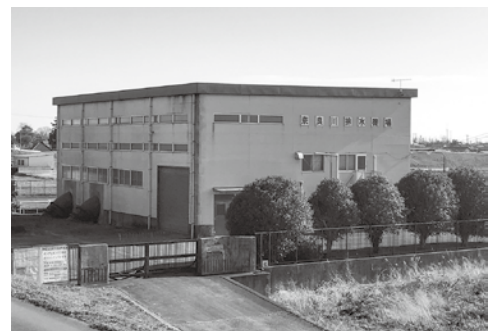
改修される奈良川排水機場
