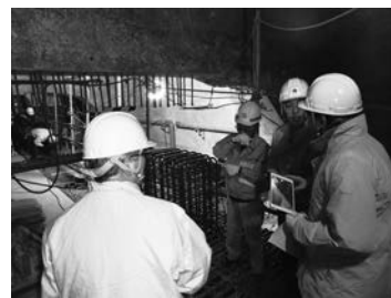
耐震化改修工事の視察中
