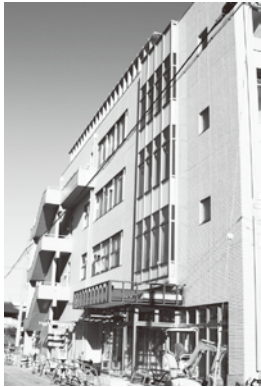
建設中の熊谷東公民館
