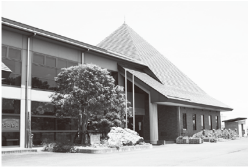
廃止となる大里保健センター
