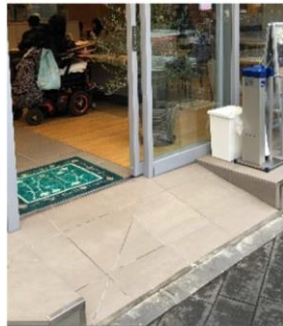
スロープの設置
