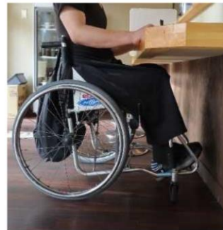
ローカウンターを設置
