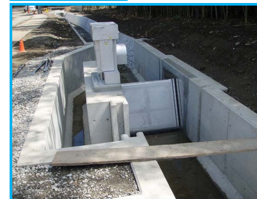
用水を分水するために水位を上げる施設
