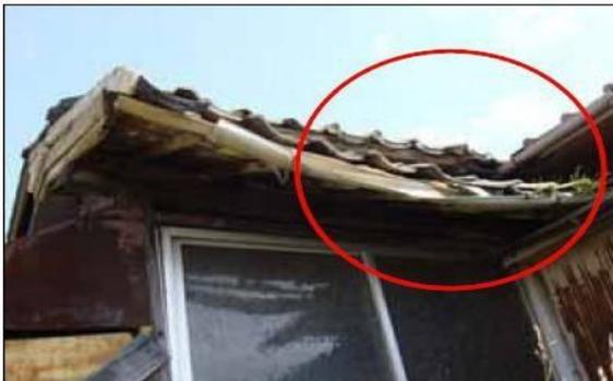
軒の裏板、垂木等が腐朽し、軒が垂れ下がっている例（評点25点）
