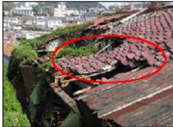
柱、はりの破損や変形が著しく崩壊の危険がある例（100点）
