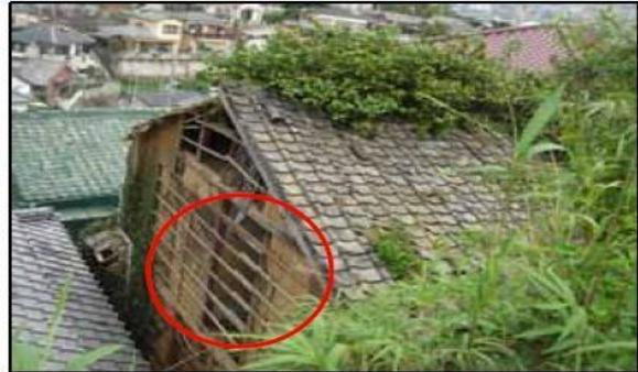
外壁が剥落し、著しく下地が露出するとともに、壁体を貫通する穴を生じている例（評点20点）
