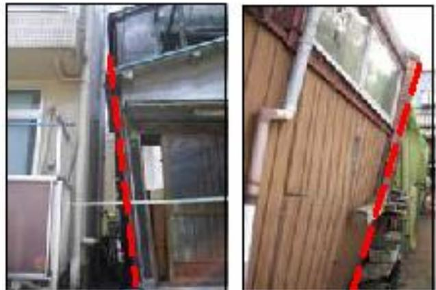
柱の変形が著しく崩壊の危険がある例（100点）
