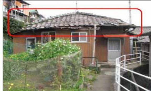
屋根に不陸（凹凸）がある例（評点50点）
