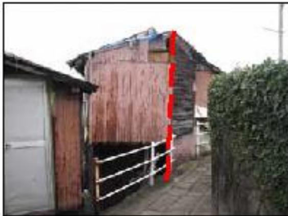
一部の柱が傾斜している例（25点）
