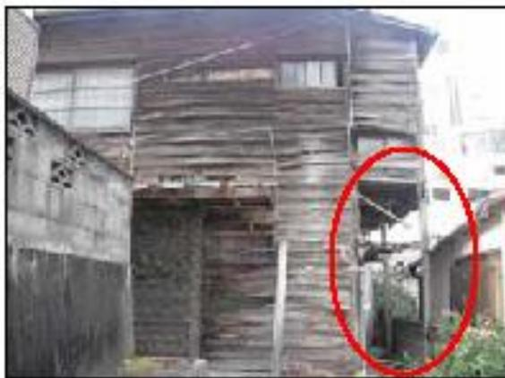
柱の数ヶ所に破損がある例（50点）
