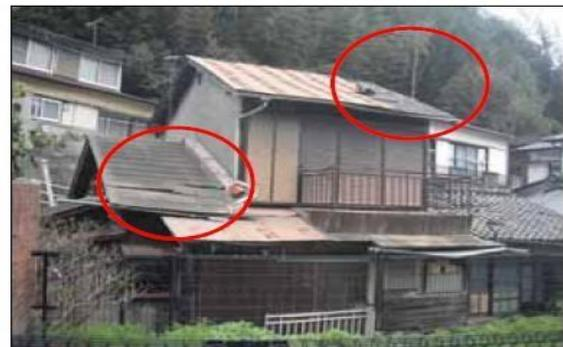
アスファルト屋根等の一部にズレがあり、雨漏りのある例（評点15点）
