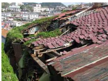
①屋根ぶき材料に著しい剥落がある例
