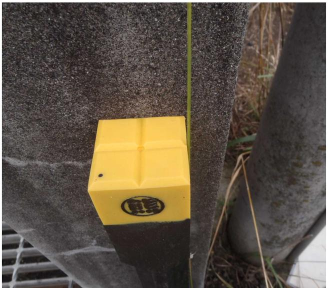
コンクリート杭、プラスチック杭の多くは、地中に埋まっていますので、通常見える部分は右のように頭の部分だけです。
