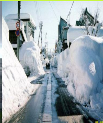
雪害 新潟県津南町
