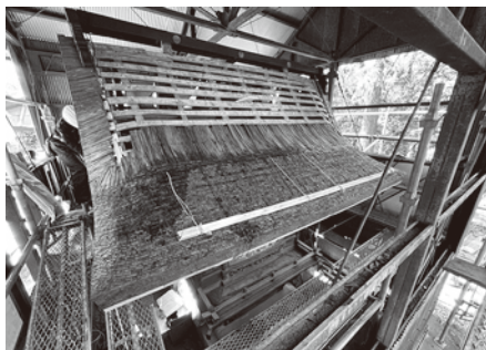
ひ わ だ ぶ ぎ や ね ぶ ぎ か 檜皮葺屋根葺替えの様子
