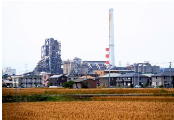
麦畑と民家とセメント工場
