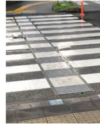
図 13 音響式信号機 写真 8 エスコートゾーン
