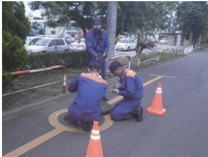
消防水利点検
