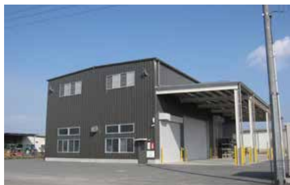
〔乾燥調整施設〕
