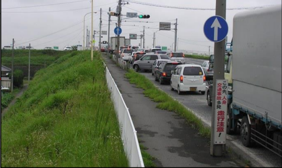
国道407号 刀水橋（南）
