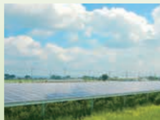
調節池を利用したメガソーラー
