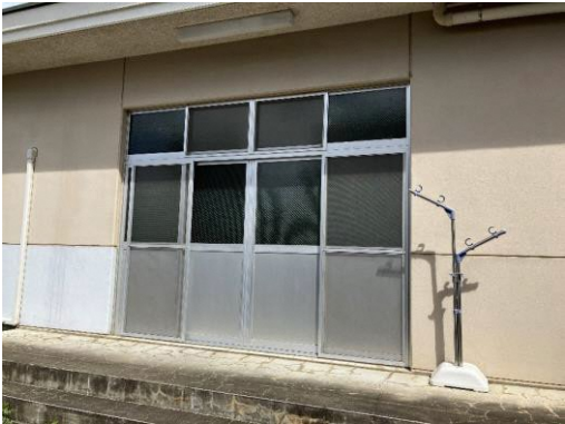
②南面（想定搬入口）
