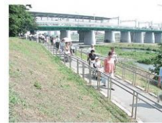
【バリアフリーのスロープの整備（多摩川）】
