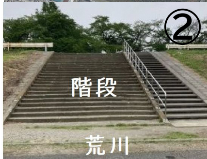
階段(堤外地側)
