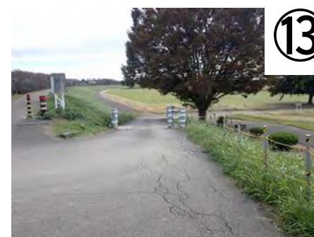
桜木小学校前の坂路 （堤外側）
