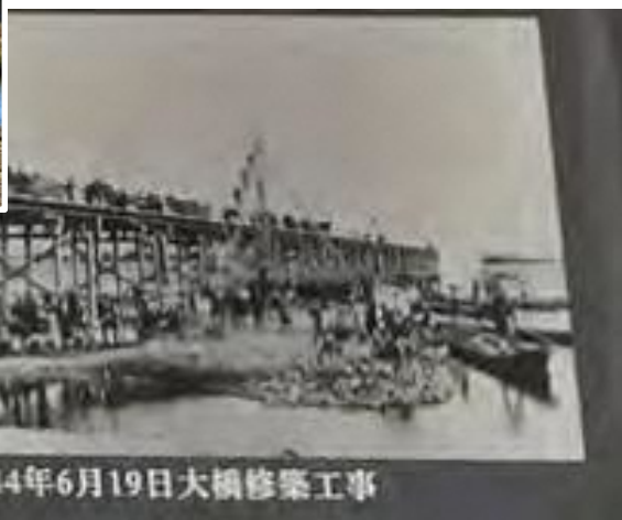
荒川大橋改修工事
