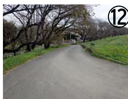
桜木小学校前の坂路 （堤内側） （高低差4m程度 急勾配15%程度）
