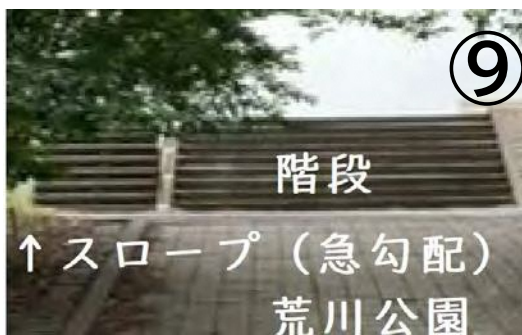
階段 ↑スロープ（急勾配） 荒川公園 バリアフリーなアクセスを損ねる階段、急勾配斜路 市民体育館前（堤内地側）
