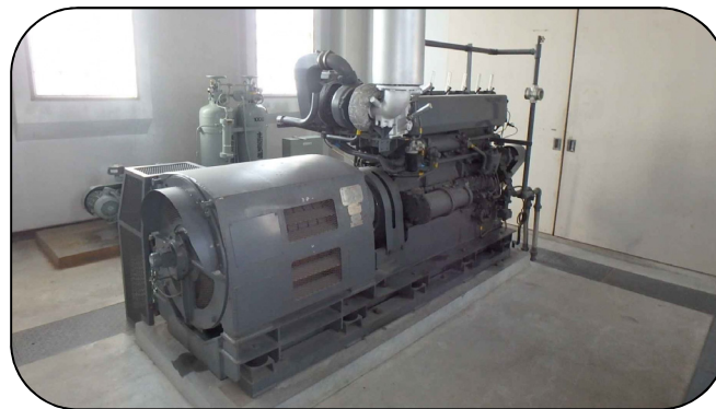
図 3-4.自家発電設備（1976年製）
