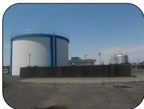
妻沼第2浄水場 施設能力 5,960m 3 /日
