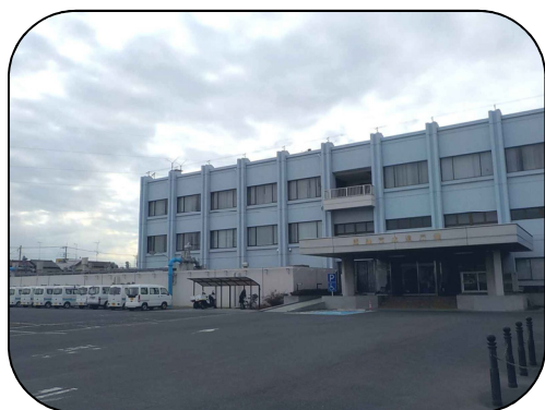
東部浄水場 施設能力 50,000m 3 /日
