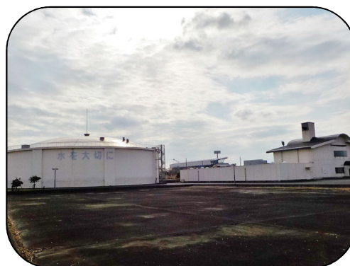
北部配水場 施設能力 10,810m 3 /日
