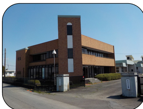
妻沼第1浄水場 施設能力 3,000m 3 /日
