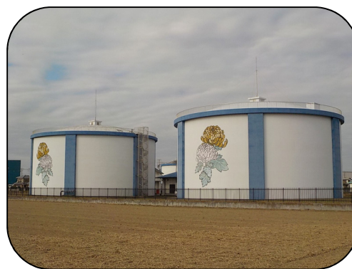
妻沼新第2浄水場 施設能力 15,800m 3 /日
