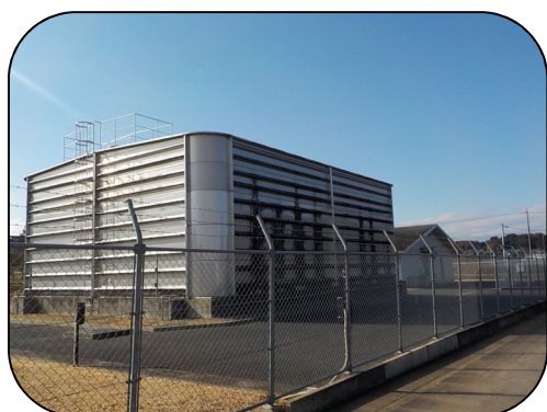
小江川増圧配水場 施設能力 1,356m 3 /日
