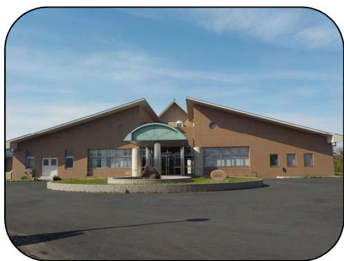
玉作浄水場 施設能力 2,600m 3 /日
