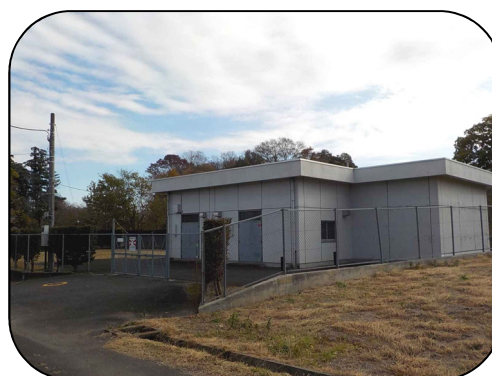
塩増圧配水場 施設能力 890m 3 /日
