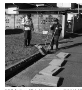
側溝蓋上げ機を使用している側溝清掃
