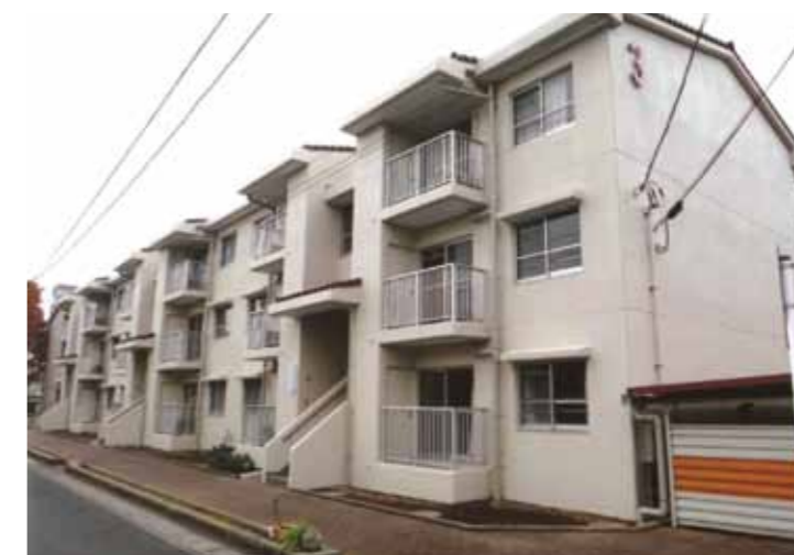
外壁改修後の市営籠原住宅 3 号棟
