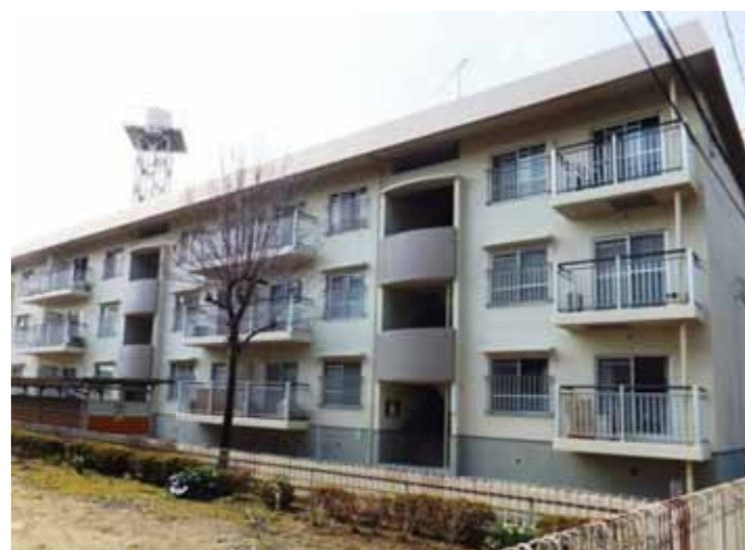
外壁改修後の市営中妻住宅 1 号棟
