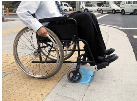
熊谷UDブロックが設置された交差点
