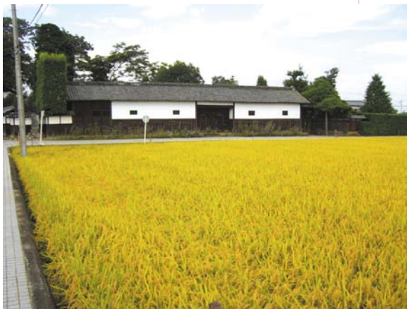
江南地区に残る長屋門
