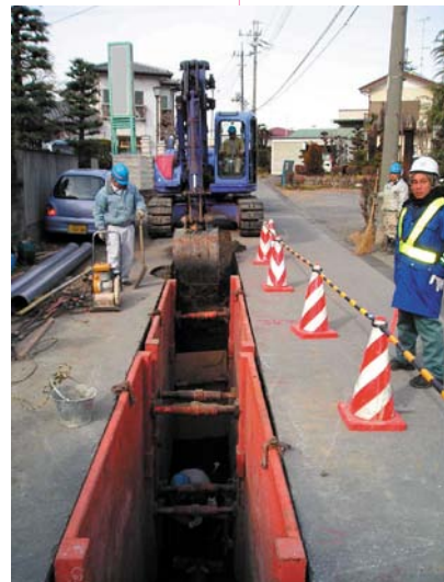
整備が進む下水道
