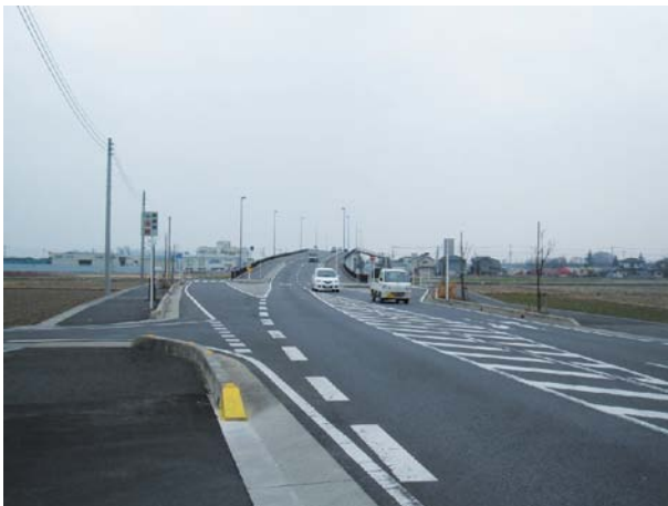
市道130号線「佐谷田第二陸橋」
