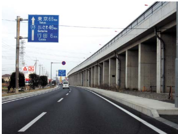
熊谷バイパス「柿沼肥塚立体」
