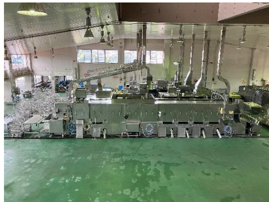
コンテナ室（床の修繕が必要）
