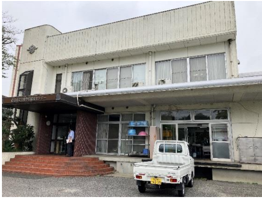
センターの建物及び荷受室
