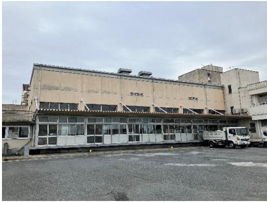
建物外観及び配送回収プラットフォーム
