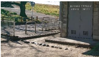
南西側出入口
